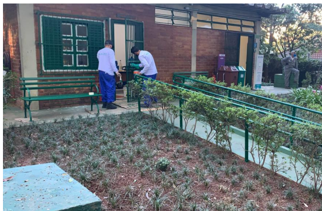
Figura 43: Pintura das portas, janelas e gradis
