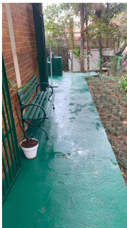
Figura 45: Piso de acesso depois da pintura
