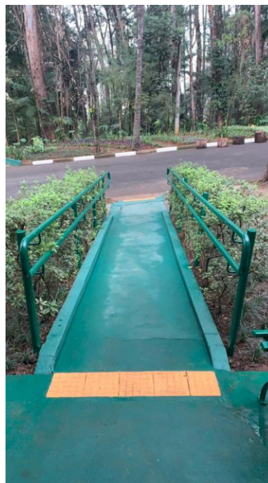
Figura 47: Piso de acesso e piso tátil da administração (depois)
