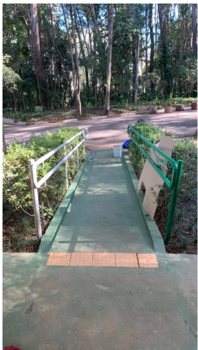
Figura 46: Piso de acesso à administração (antes)
