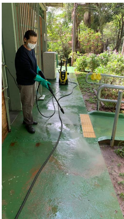
Figura 44: Piso de acesso antes da pintura
