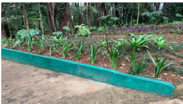
Figura 49: Manutenção do muro (depois)
